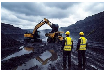
Sécurisation des travailleurs isolés
