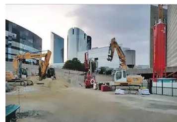
Protéger les sites en construction
