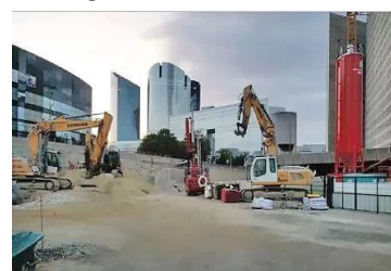
Protéger les sites en construction
