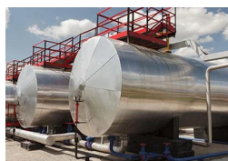
Surveillance de réservoirs
