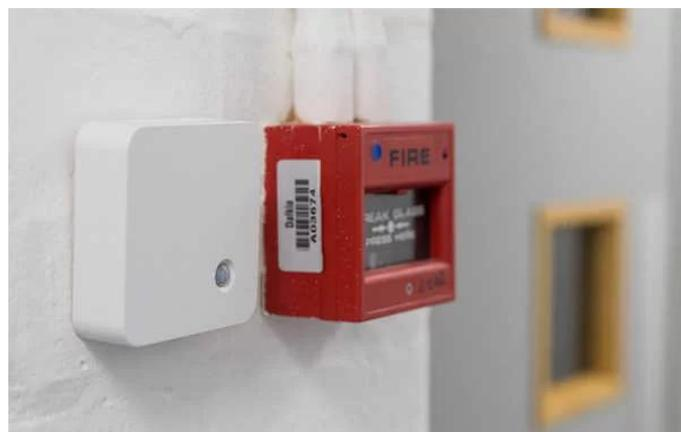
Ce capteur LoRaWAN™ 5-en-1 fournit un échantillonnage toutes les 15 minutes par défaut (configurable) pour alerter instantanément sur les conditions environnementales, et d'une présence.
