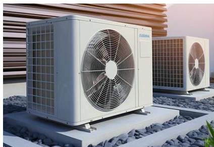
Supervision des installations CVC
