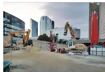
Protéger les sites en construction
