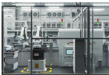
Automatisation des machines
