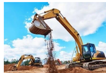
Site de construction
