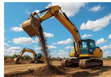
Site de construction
